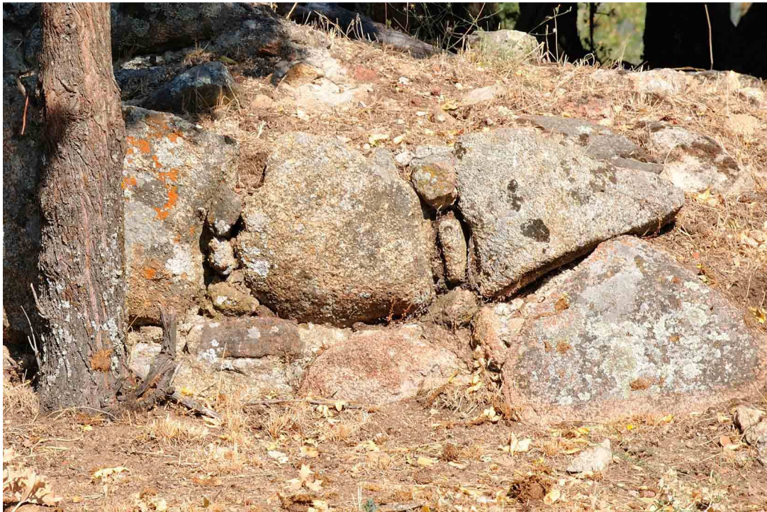
Figura 10.- Detalle del aparejo de la torre suroriental del castillo de Navarredonda. Fotografía: Juan Carlos Martín Lera. Archivo D.G.P.H.
